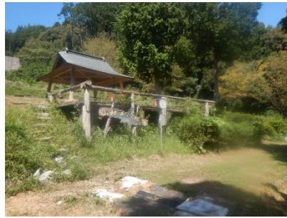
展望台解体前
